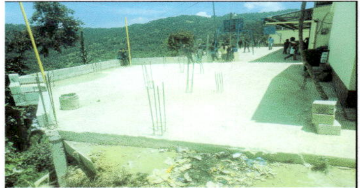
Foto 4: Reparación de muro terminado
